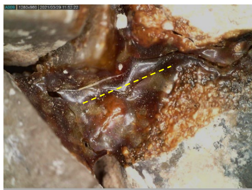
Fig. 22 : Dépôt bullé présentant une fissure sur la partie la plus fine (en pointillé jaune)
