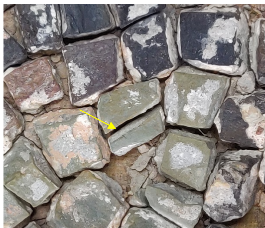
Fig. 29 : Présence de ciment à l'interface de la fracture
