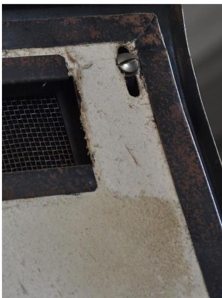
Figure 95 : Amiante en plaque, faiblement aggloméré
