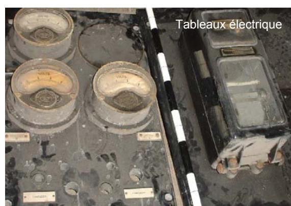
Fig.39 – Empoussièrement sur les divers éléments de l'appareillage 451
