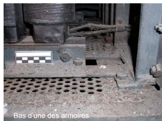
Fig.39 – Empoussièrement sur les divers éléments de l'appareillage 451
