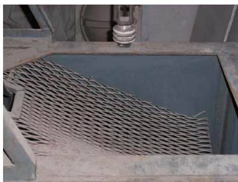
Fig.54 – Grille supérieure du redresseur n°1 466
