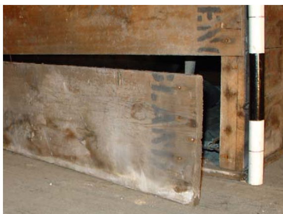
Fig.63 – Déchaussement d'une planche du bas de la boîte en bois contenant l'ampoule cassée 475
