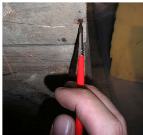
Fig.81 – Application du produit Ballistol sur une tête de clou 500
