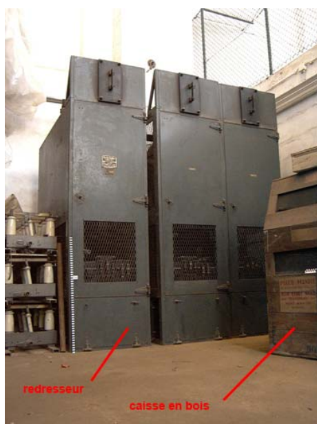
Fig.29 – Redresseurs et caisse en bois 432
