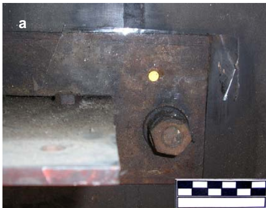
Fig.84 – Elimination des résidus de mercure présents sur les panneaux à l'aide de ruban adhésif : a - ruban collé sur la surface comportant les résidus et b - résidus de mercure fixés sur la face collante du ruban, une fois retiré
