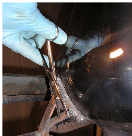
Fig.87 – Egalisation de l'isolation en amiante au ciseau
