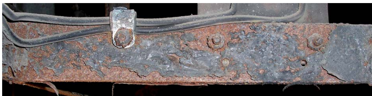
Fig.56 – Détachement de la peinture et oxydation des éléments en acier de la structure de l'ampoule 468
