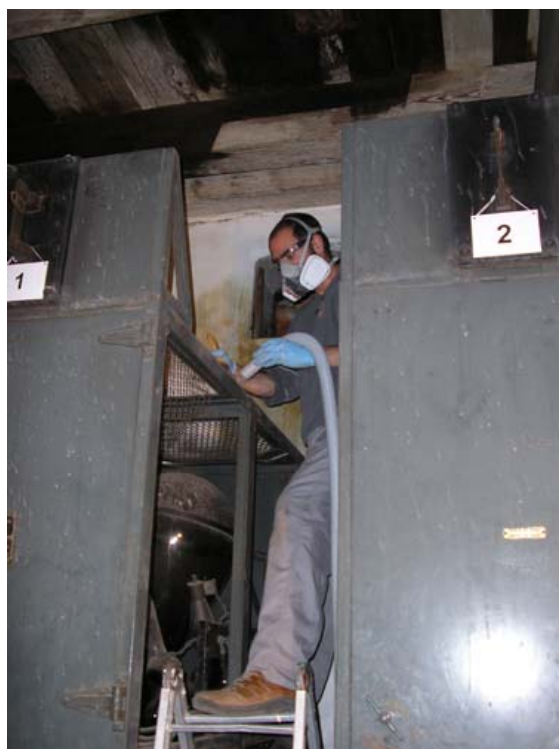
Fig.85 – Elimination des poussières sur l'ensemble de l'appareillage à l'aide de pinceaux et d'un aspirateur
