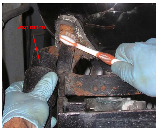
Fig.88 – Elimination des produits de corrosion à la brosse 511
