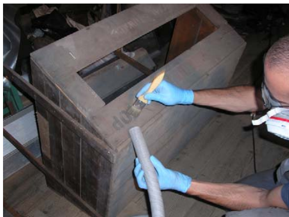
Fig.80 – Elimination des poussières de la boîte en bois avec pinceau et aspirateur 499
