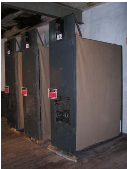
Fig.91 – Les trois redresseurs protégés à l'aide de toile épaisse en coton 513
