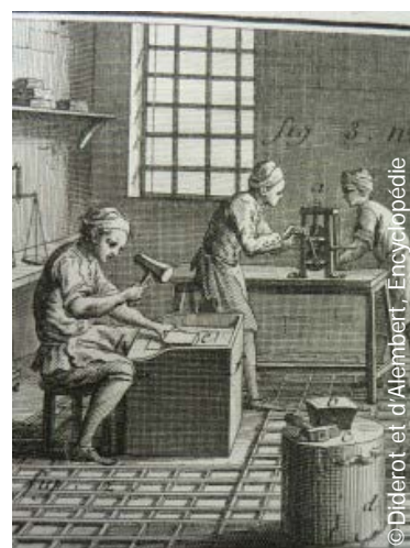
Figure 23 : Battage d'une feuille d'argent.
