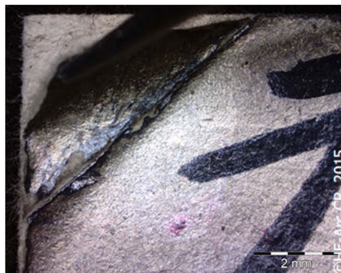
Figure 31 : Pliure et fissure de la couche métallique sur une zone de recourbement. (IId902.16).
