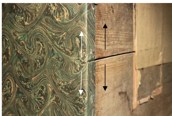
Fig. 133 : Fissure avec direction des tensions
