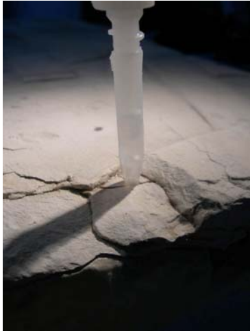
Abbildung 123: Infiltration von Paraloid® B72.
