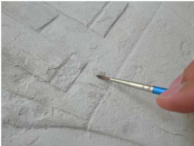
Abbildung 125: Infiltration von Primal AC 33 in einen Riss einer Scholle mit einem feinen Pinsel (n°1).
