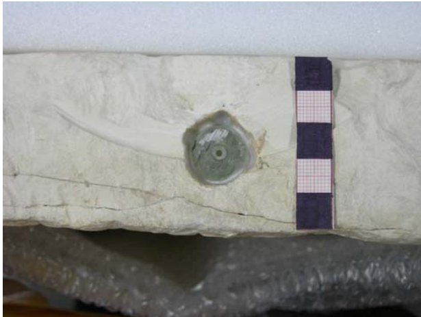
Abbildung 109: Fertig geklebtes Dübelloch.
