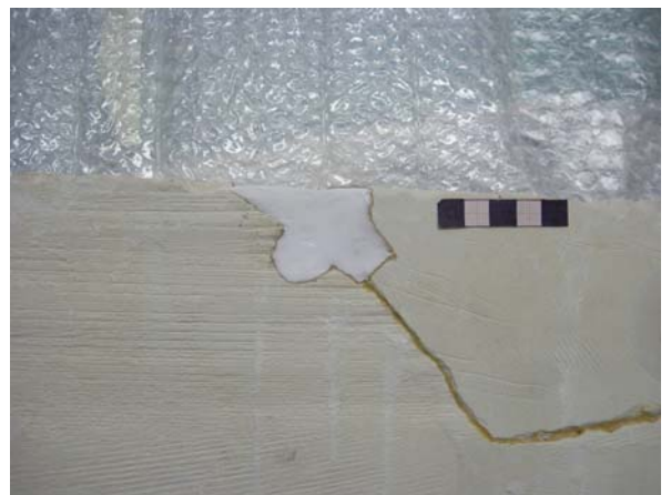
Abbildung 120: Die selbe Fehlstelle wie bei Abb. 119 in ergänztem Zustand.
