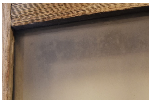
Figure 12 : Couche de dégradation du verre, conservée lors du nettoyage
