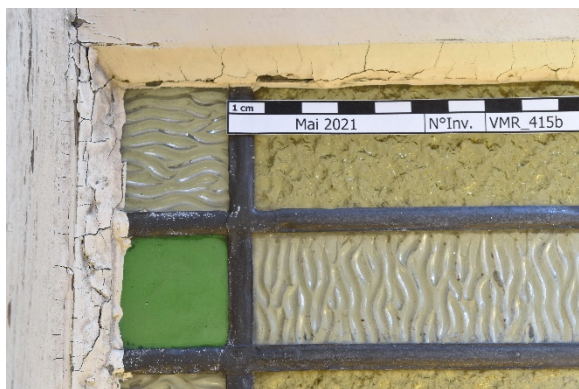
Figure 44 : VMR_415b, craquelures et écaillage
