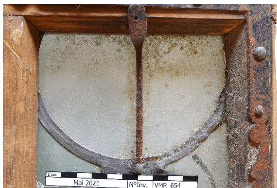
Figure 32 : VMR_654, corrosion du fer et taches sur le verre
