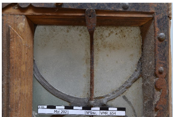
Figure 111 : VMR_654, encrassement avant nettoyage
