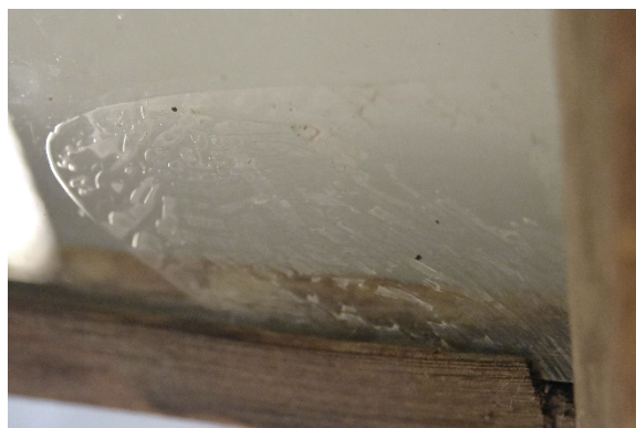
Figure 123 : VMR_10054, altération du verre rendue visible par le nettoyage
