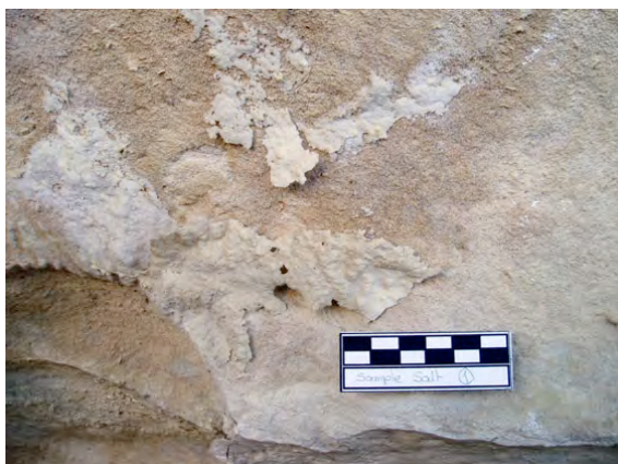
Photo 46: Sel prélevé n°1, situé à gauche de l'alcôve, à moins d'un mètre du sol, et formant une croûte qui se détache de la roche
