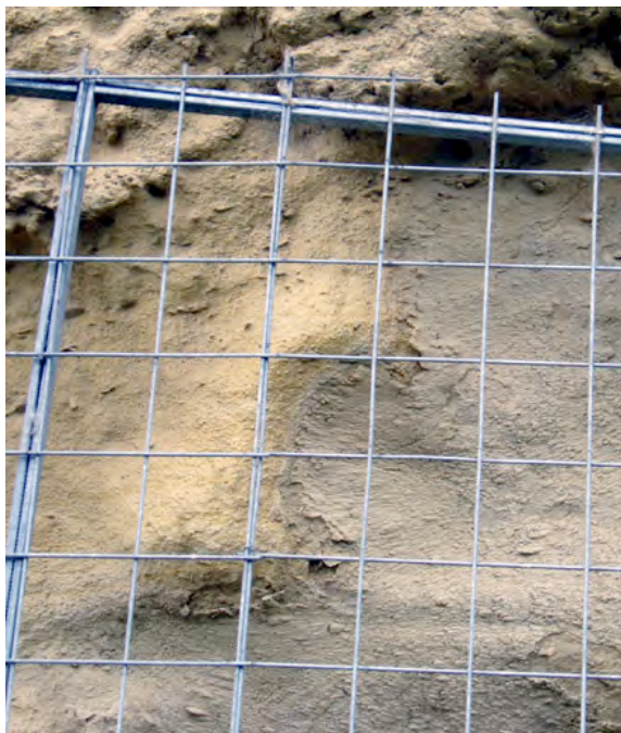
Photo 69: Accumulation de poussière sur une zone visiblement plus humide.
