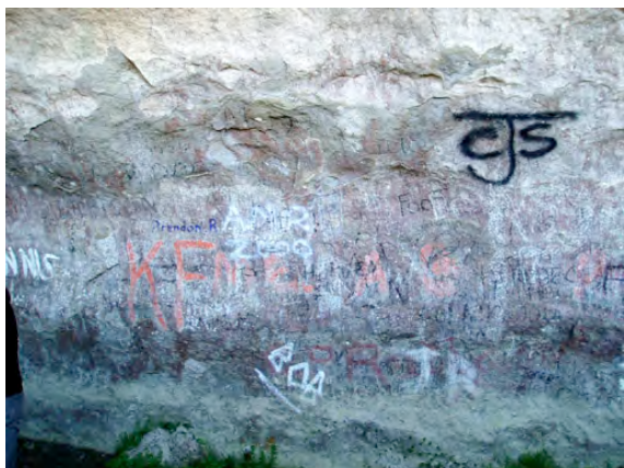
Photo 1: Vandalisme important sur le site de "Hanging Rock Bridge" en Nouvelle-Zélande. Les motifs maoris originels sont presque invisibles sous les tracés modernes
