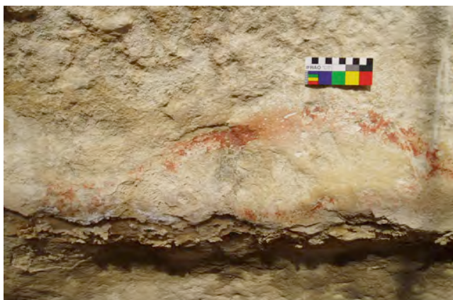
Photo 30: Zone située à l'angle d'un surplomb et présentant un phénomène de désintégration de la roche.
