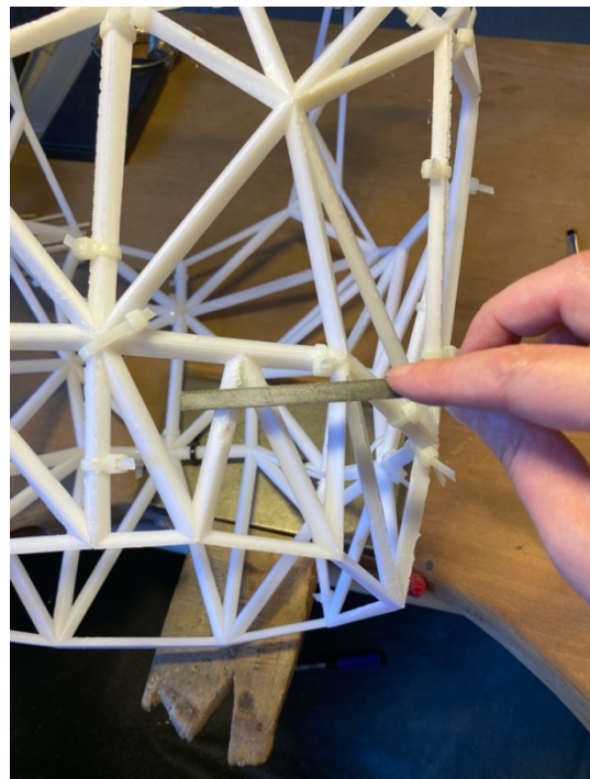
Figure 84 Égalisation des pièces avec une lime. © HE-Arc, MP Mottaz, 2020.
