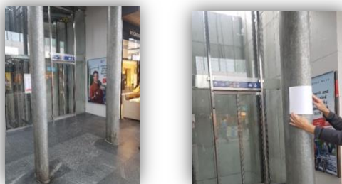
Abb.23: Auf dem zweiten Bild wird aufgezeigt, wie eine weisse Markierung den Pfeiler hervorheben würde und besser sichtbar wäre (siehe Sozialraumforschung, S. 11, 12).
