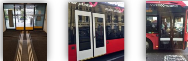
Abb.19: Kontraste dienen als Markierungen, welche wichtige Hinweise geben. Sie befinden sich beispielsweise an Türen, am Boden, an Schaltknöpfen oder bei Treppen. (siehe Sozialraumforschung, S. 31, 39)
