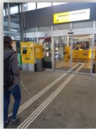
Abb.21: Gutes Beispiel vom Bahnhof Bern, wie taktil-visuelle Leitlinien durch einen Teppich auch im Innern eines Gebäudes weitergeführt werden können. (siehe Sozialraumforschung, S. 22)
