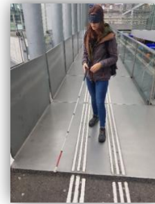
Abb.13: Abzweigungsfelder weisen auf einen möglichen Richtungswechsel hin (Sozialraumforschung, S. 16; S. 20; S. 17)
