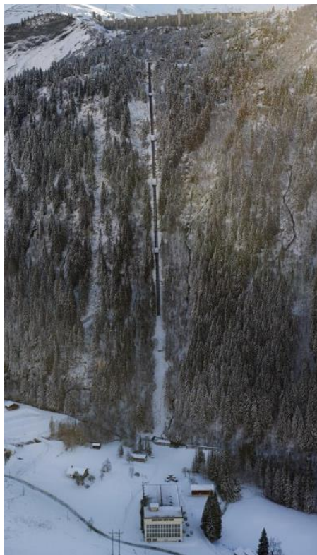
Figure 29 - Centrale hydroélectrique de Belleville, sa double-conduite forcée et le barrage de La Girotte
