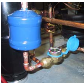
Fig. 3.2.7.1 Filtre déshydrateur et voyant
