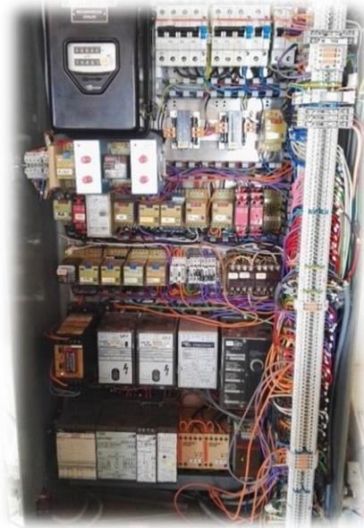
Figure 12: Tableau de commande turbo-groupe 4
