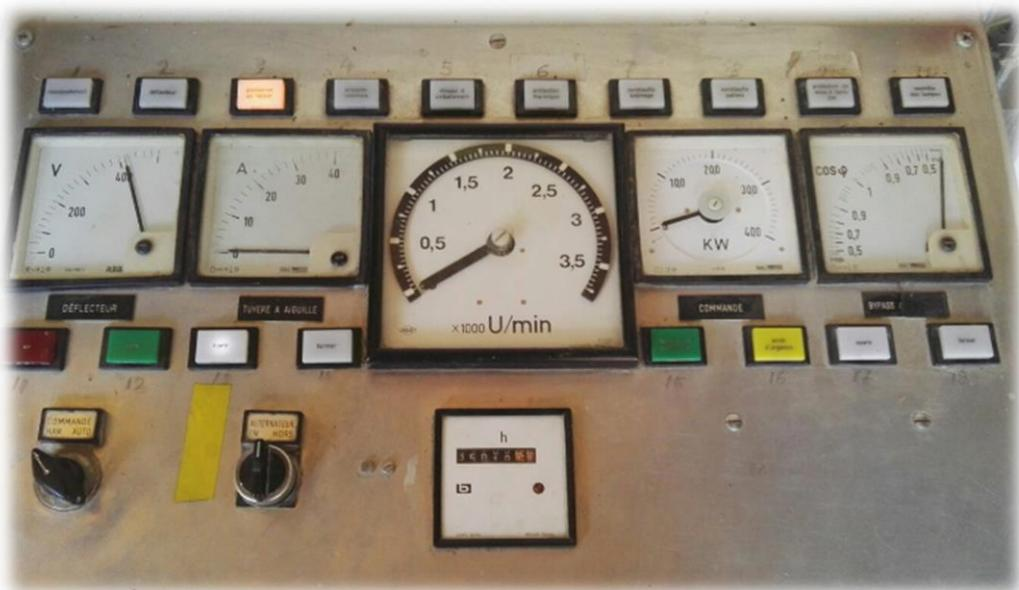
Figure 14: Tableau de commande turbo-groupe 1
