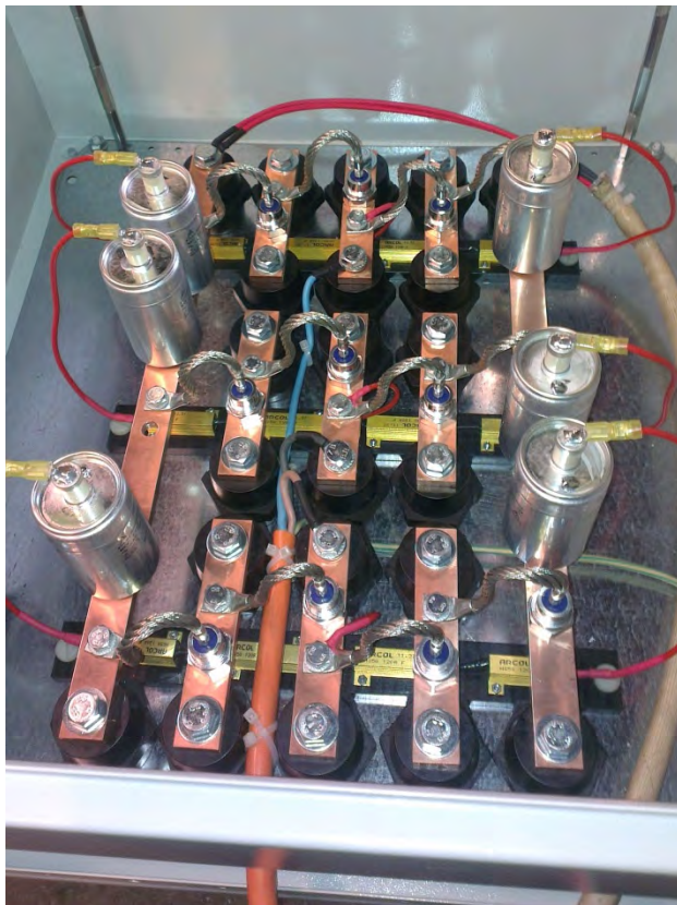
Figure 119 : Coffret du redresseur : vue intérieure
