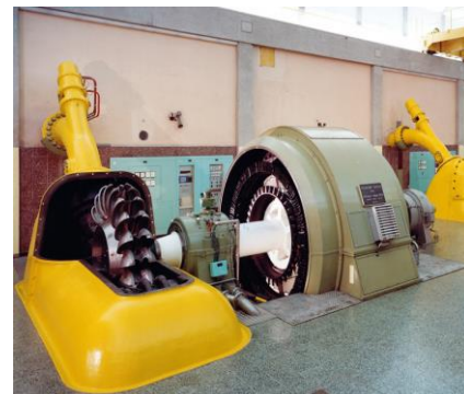
Groupes de production de la centrale de la Croix avec la turbine Pelton dans le bloc jaune et l'alternateur dans le bloc vert.
