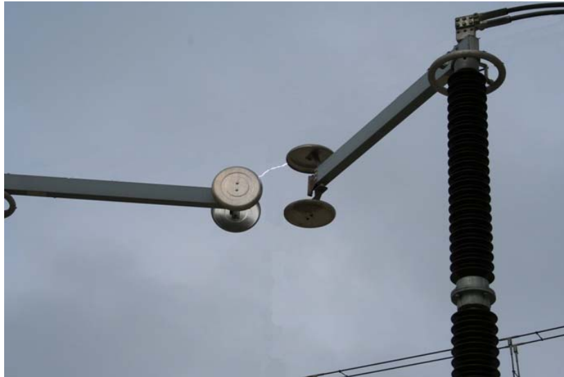
Abbildung 6.10: Drehtrenner für 400 kV bei einem Schaltvorgang [16]
