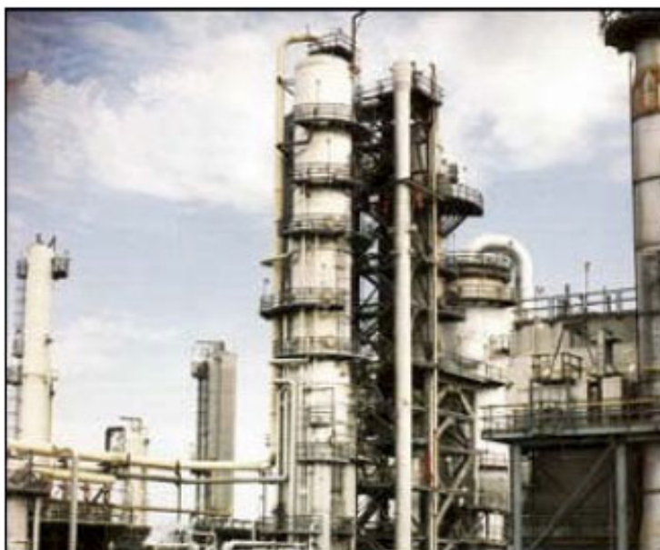
Figure 1 : Réacteur à lit fluidisé pour le cracking du pétrole
