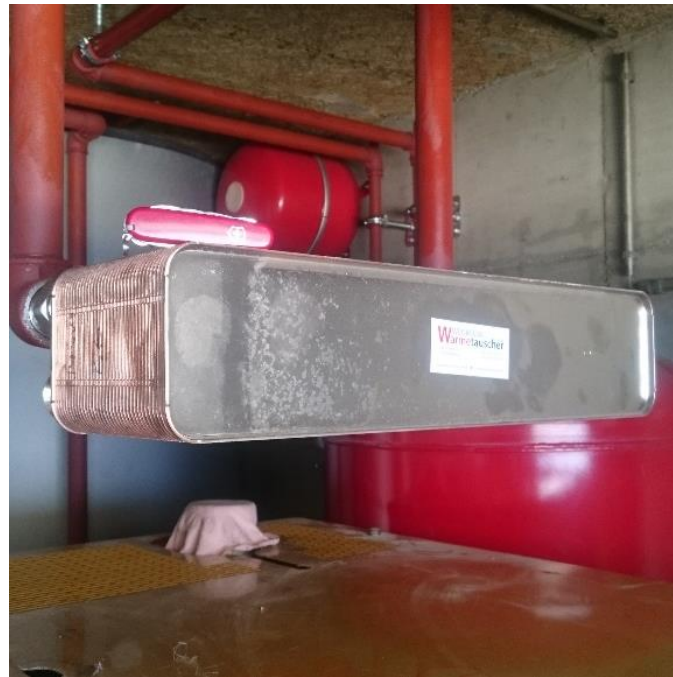
Figure 39: Echangeur à plaque 25 kW sur eau de radiateur
