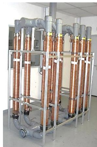
Figure 32: Exemple d'installation de "Power Pipe"
