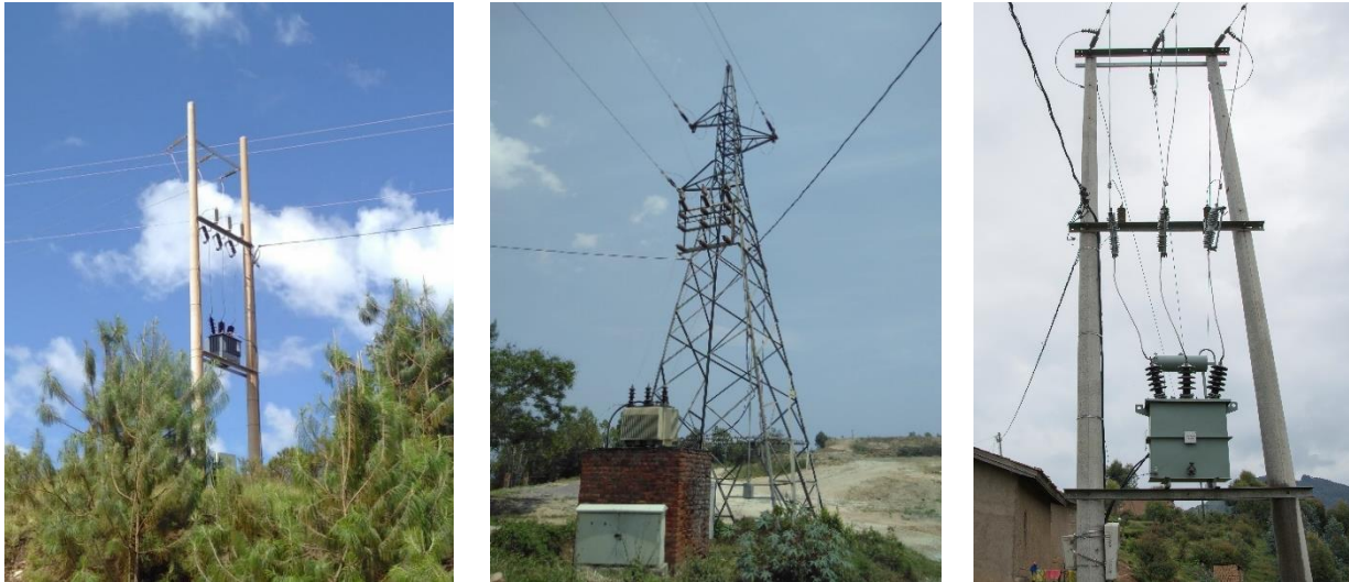
Photo 11 : Exemples de distributions MT - BT au Rwanda
