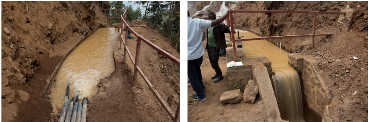
Photo 5 : Dessableur et déversoir du canal d'irrigation
