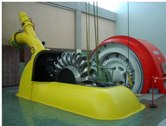
figure 2: Turbine et alternateur de la centrale de Croix
