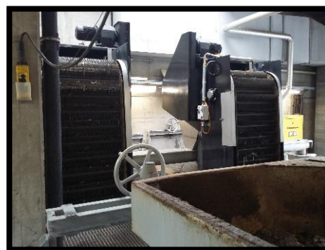
Figure 23 : Tamiseurs (3)
