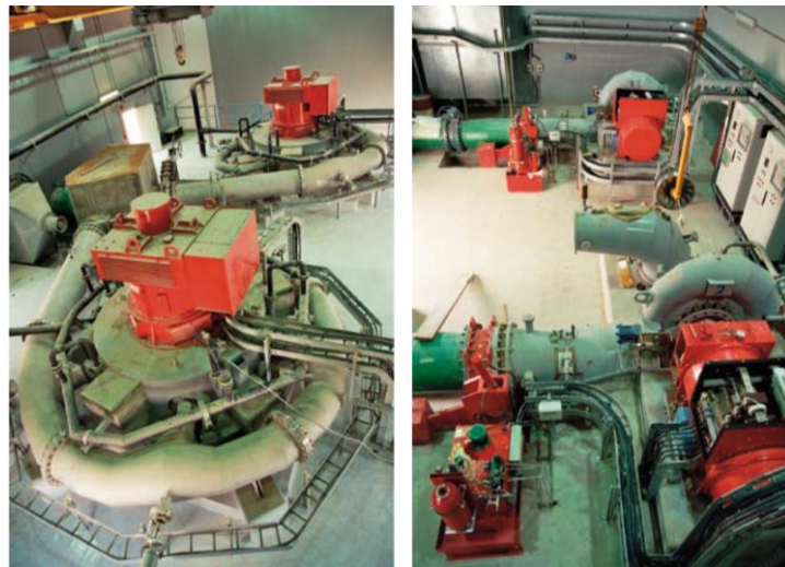
Figure 9 : Turbines Pelton à axe vertical (gauche) et Francis à axe horizontal (droite) [12]
