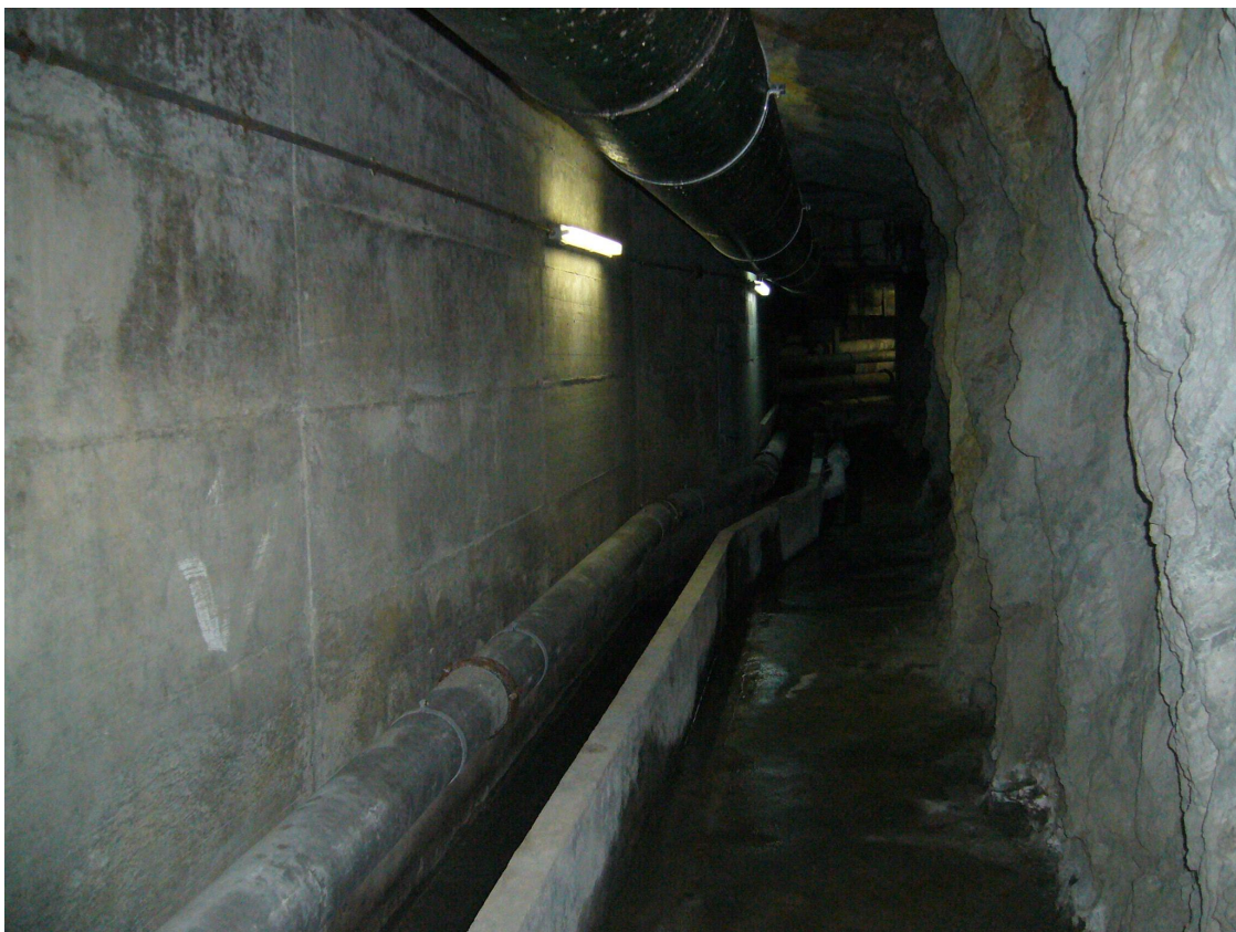
Abb. 4: Zugangsstollen zu den Durchflussmessstellen der Pumpgruppen 1 und 2
