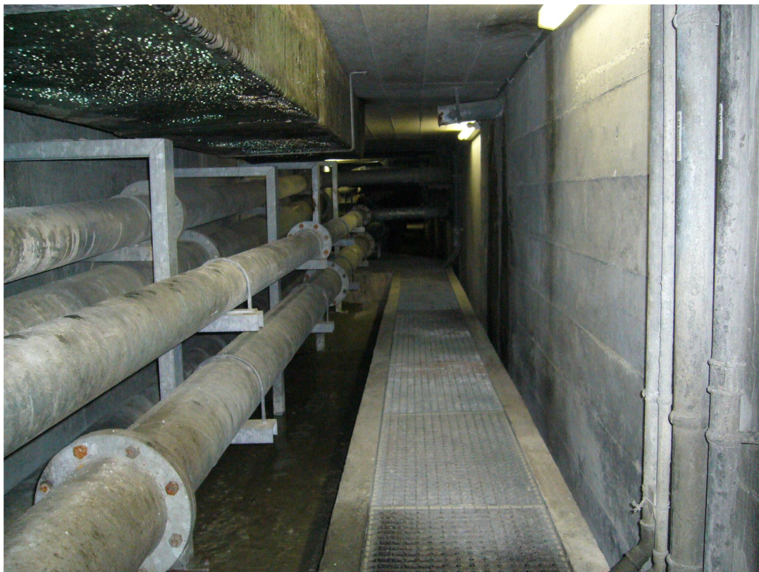
Abb. 5: Zugangsstollen zu den Messstellen der Pumpgruppen 1 und 2
