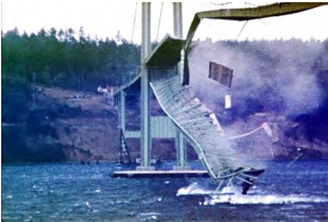
Abbildung 47: Die Brücke Tacoma Narrows stürzte am 7. November 1940 aufgrund von Resonanzschwingungen ein
