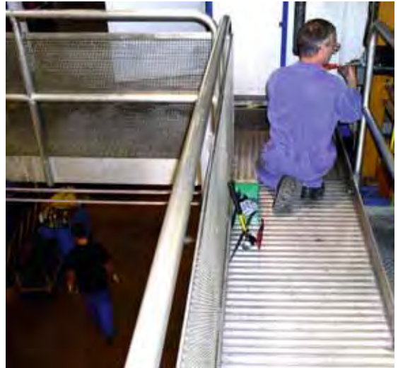
Bild 20 Geländer entlang einer Arbeitsbühne mit Fussleiste und einer vollflächigen Füllung auf der Absturzseite. Dadurch wird verhindert, dass kauende Personen oder Gegenstände auf den darunterliegenden Verkehrsweg abstürzen.
