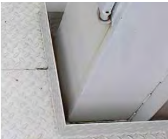
Bild 9 Fussleiste um eine Bodenöffnung, deren horizontaler Abstand zur Säule mehr als 30 mm beträgt.
