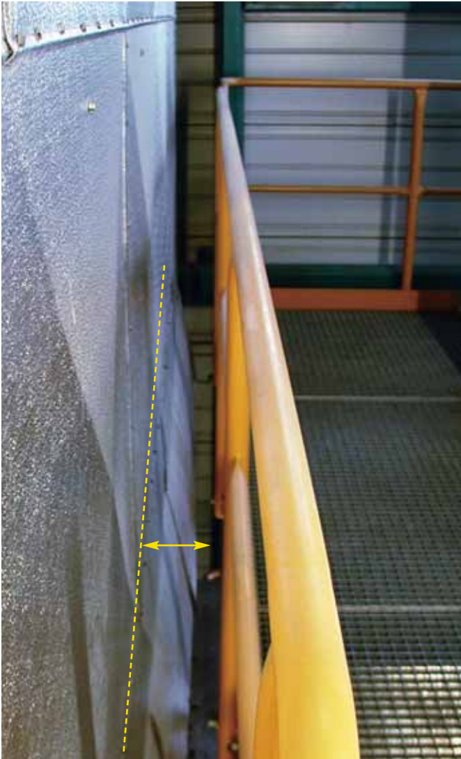
Bild 7 Geländer zur Sicherung der maschinen- bzw. wandseitigen Absturzkante. Das Geländer ist erforderlich, weil der Abstand der Lafebene zur seitlichen Maschinenverkleidung bzw. zur Wand mehr als 200 mm beträgt.
