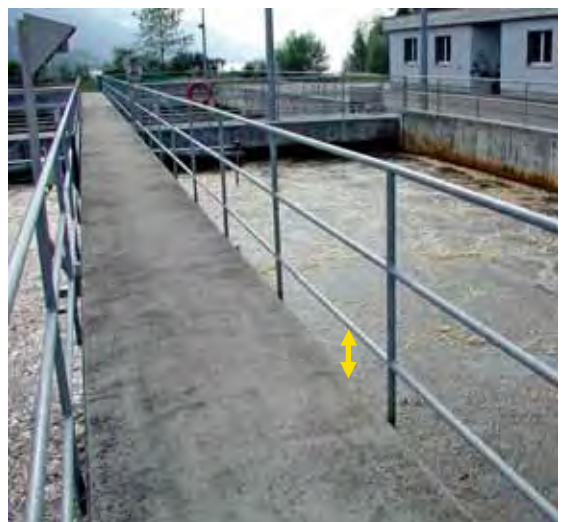
Bild 21 Durch den Zwischenraum zwischen Lafebene und Fussleiste kann Regen- und Schmelzwasser abfließen. Der Zwischenraum beträgt nicht mehr als 10 mm.
