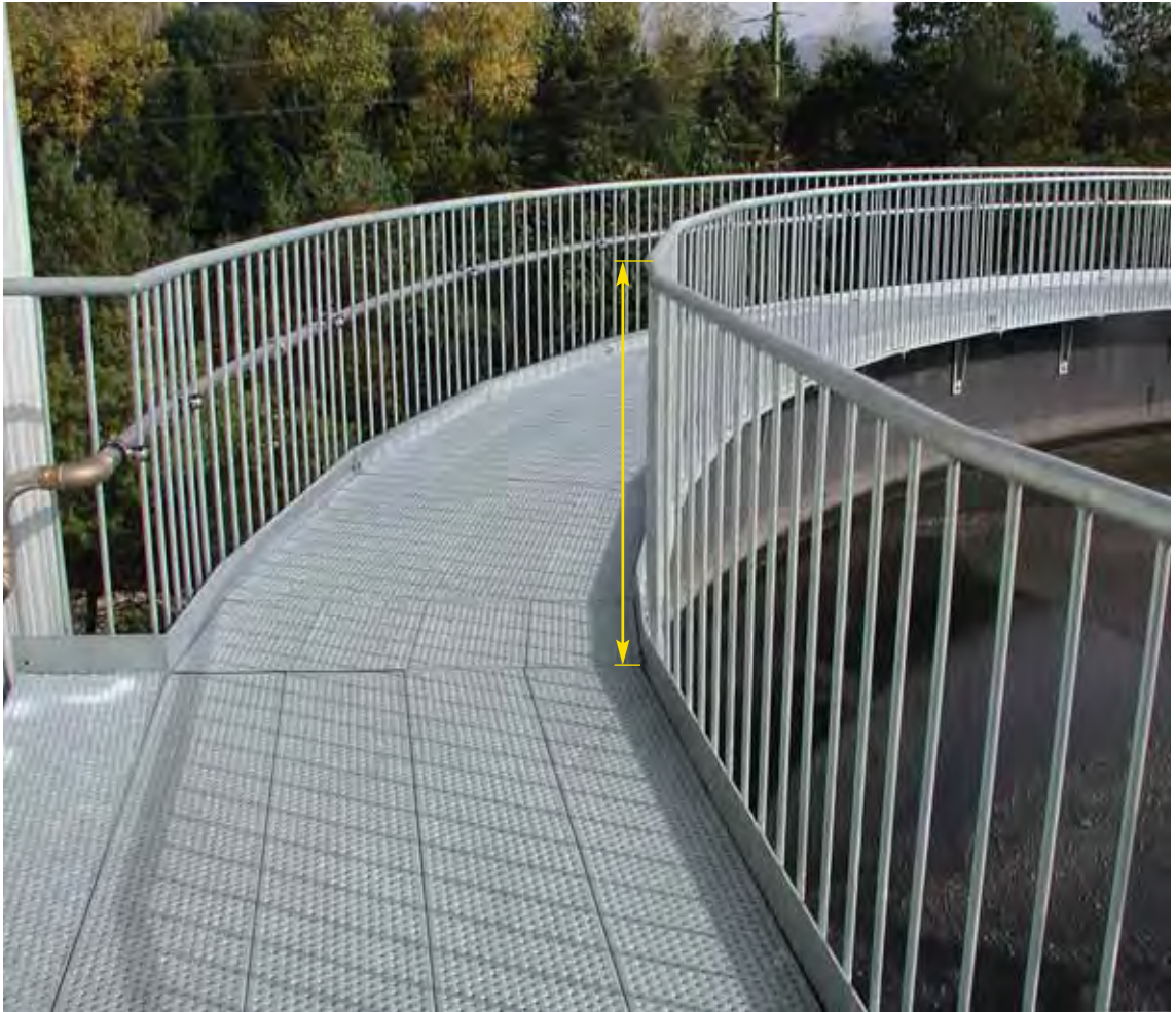
Bild 10 Die Geländerhöhe beträgt 1,1 m – von der Lafebene zur Oberkante des Handlaufs gemessen.
