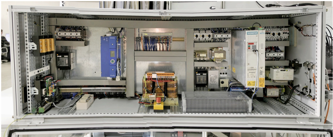
Abbildung 2.5: Der Schaltschrank mit bereits der neuen SPS in der Mitte
