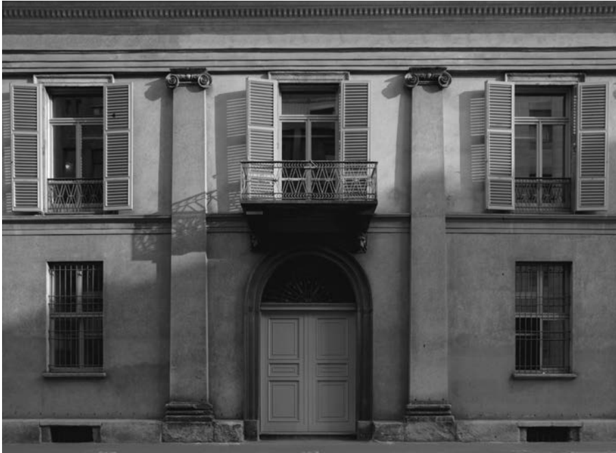
Fig. 15. Casa Canonica in via Sant'Agnese, Milano; veduta parziale del fronte nello stato attuale.
