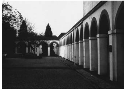
Fig. 3 e 4. Félix Delarue, Asile du Gué-de-Maulny , bâtiments de la porterie depuis la rue et grande cour centrale partie nord-ouest.
