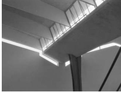
Stabilmienti Cedis, Palermo 1955-1956, elemento strutturale con incorporati i canali per lo smaltimento delle acque piovane. Veduta durante il cantiere e veduta del- l'interno a progetto ultimato (AdM, Fondo Marco Zanuso , MZ A FOT S 48).
