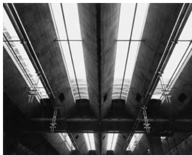
Stabilimento Olivetti Italia, Scarmagno 1972 ca. Vista delle travi secondarie cave dall'interno durante il cantiere e vista esterna a progetto ultimato (AdM, Fondo Marco Zanuso, MZ A FOT 36 e 37).
