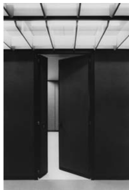
Sequenza delle fasi di montaggio dei pannelli divisorii interni del Complesso IBM a Segrate, 1968-1974 (AdM, Fondo Marco Zanuso, MZ A FOT S 42. Immagini pubblicate nell'articolo di Zanuso in "Casabella", aprile 1977, n. 424). Il sistema di pareti mobili consente di trasformare lo spazio per rispondere alle mutevoli esigenze dell'azienda.
