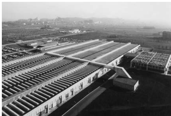
Fabbrica Olivetti, Scarmagno 1967-1972, veduta aerea e interno di un'unità organica di produzione, concepito come continuum , spazio indifferenziato che consente all'apparato produttivo la massima libertà di sviluppo (AdM, Fondo Marco Zanuso, MZ A FOT S 31).
