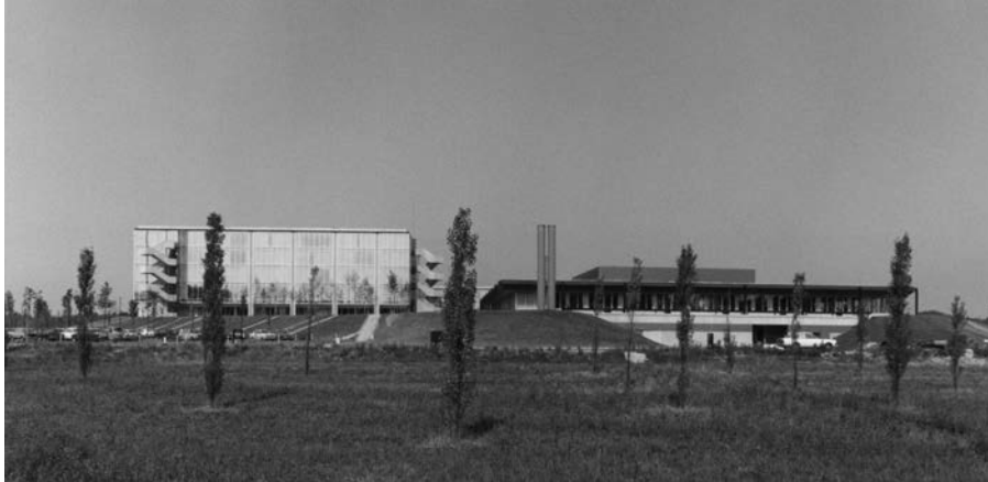
Complesso IBM, Segrate 1968-1974, vista generale. A destra, l'edificio dei servizi e a sinistra, uno dei volumi ad uffici (AdM, Fondo Marco Zanuso, MZ A FOT S 46).
