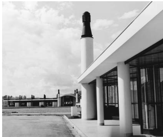
Fabbrica Olivetti, Brasile, San Paolo 1956-1961. Pilastro cavo durante il cantiere e a progetto ultimato (AdM, Fondo Marco Zanuso , MZ A FOT S 33).
