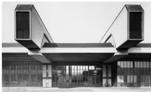
Stabilmienti Necchi, Pavia, 1960-1961. Trave cava durante il cantiere e a progetto finito (AdM, Fondo Marco Zanuso , MZ A FOT S 38).
