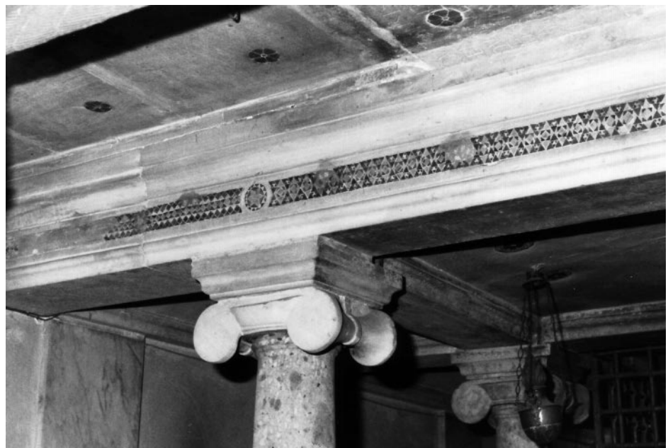
384. Rom, S. Lorenzo fuori le mura, Krypta, mittelalterliche ionische Kapitelle und Gebälkssystem (Foto Mondini 1990)
