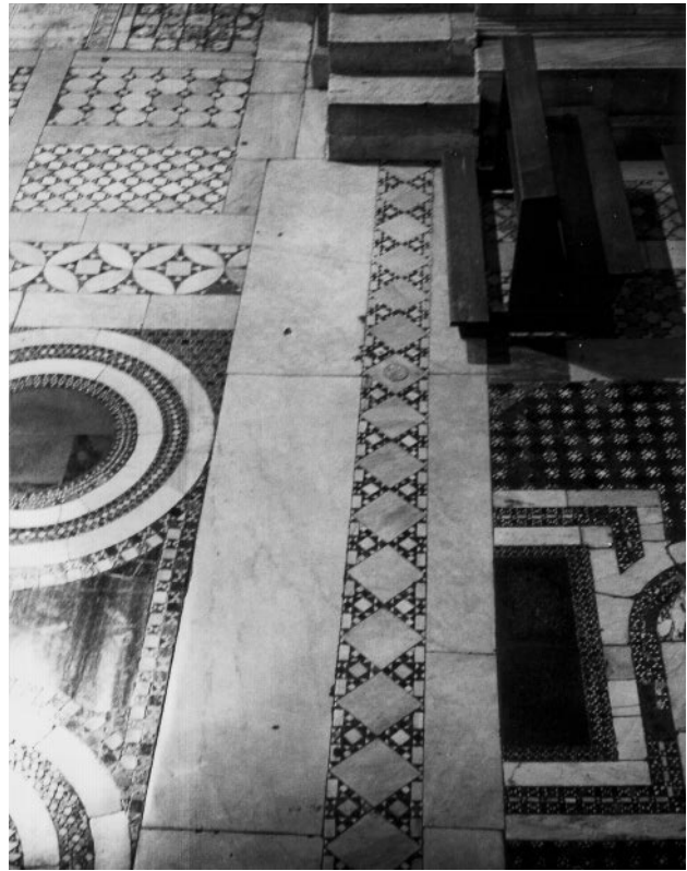
334. Rom, S. Lorenzo fuori le mura, Langhauspaviment, ehemalige Stufe des Vorchors (Foto Mondini 1990)
