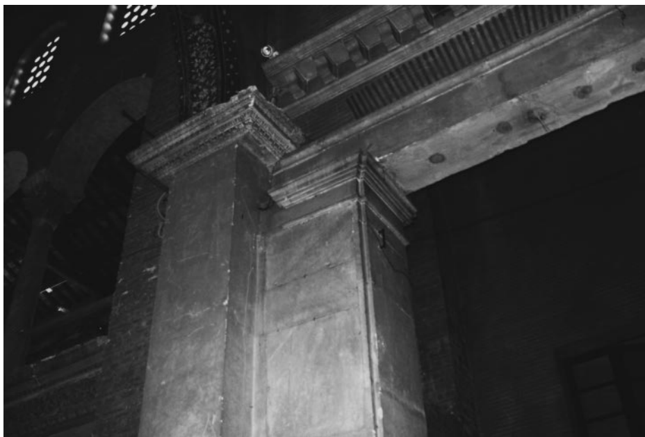
274. Rom, S. Lorenzo fuori le mura, Pelagius-Basilika, südlicher Triumphbogenpfeiler, bzw. Anschluss der Südkolonnade an den Triumphbogen (Foto Mondini 2005)
