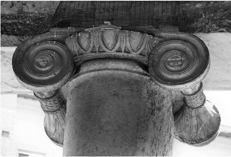
76. Rom, SS. Giovanni e Paolo, Vorhalleninnenseite, ionisches Kapitell mit Köpfchen in den Voluten- augen (Foto Senekovic 2002)
