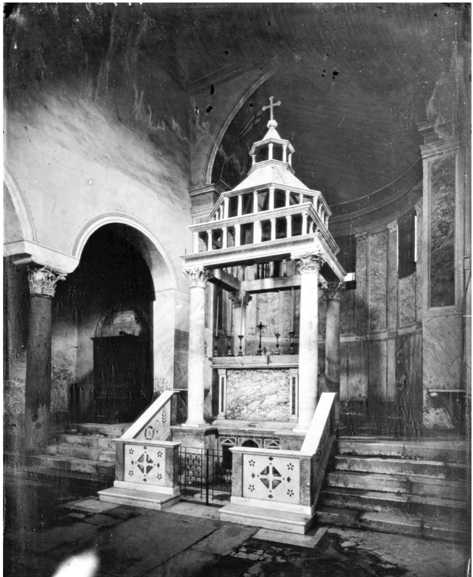
33. Rom, S. Giorgio in Velabro, Altarbereich vor der Restaurierung 1925 (ICCD)
