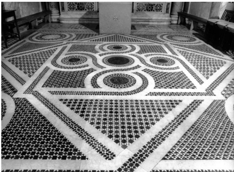
197. Rom, S. Ivo de' Bretoni, Innenansicht, Paviment. (Foto SBAS)
