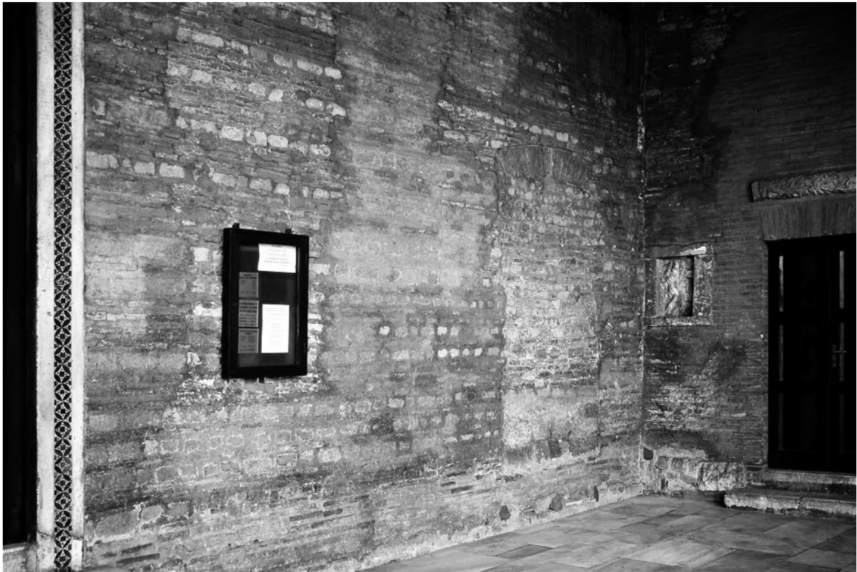
123. Rom, S. Giovanni a Porta Latina. Südliche Partie der Fassadenwand in der Vorhalle. (Foto Claussen 2002)
