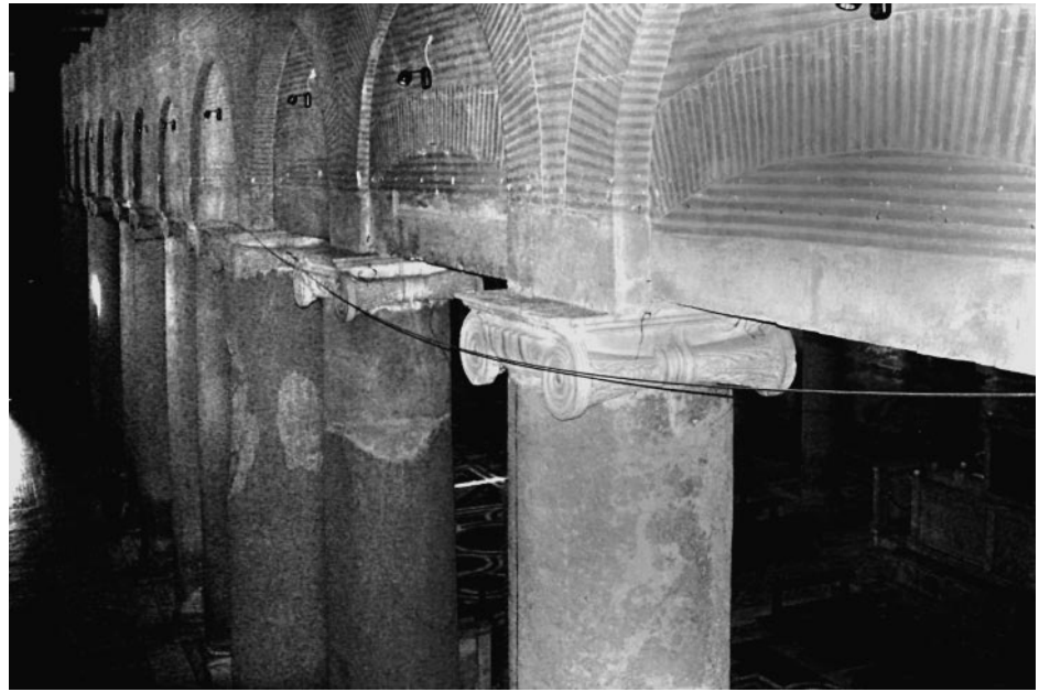
325. Rom, S. Lorenzo fuori le mura, südliches Seitenschiff Gebälk Rückseite mit Entlastungsbögen, (Foto Senekovic 2004)
