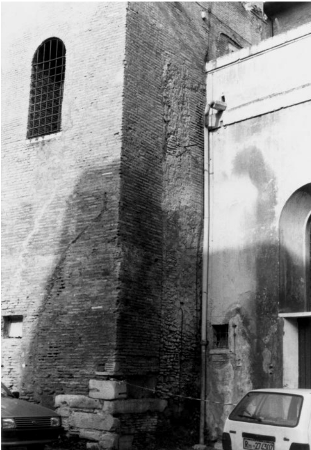
418. Rom, S. Lorenzo fuori le mura, Ansicht auf die Ostseite des Glockenturms mit älterer Zungenmauer (Foto Mondini 1990)
