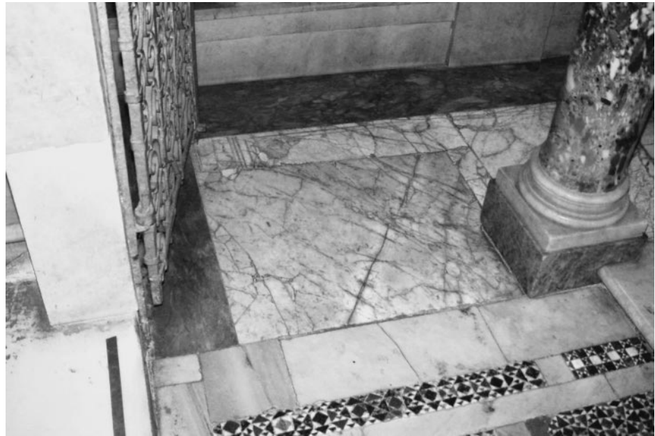
393. Rom, S. Lorenzo fuori le mura, Krypta, Paviment aus Giallo antico (Foto Mondini 2005)
