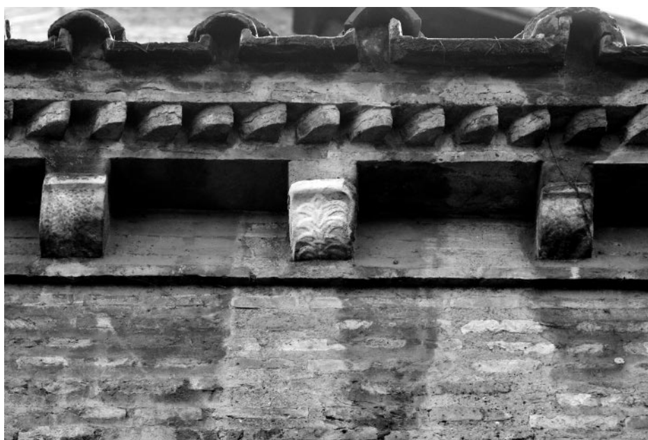
139. Rom, S. Giovanni a Porta Latina. Erneueres Abschlussgesims der Vorhalle mit wieder verwendeten Konsolen. (Foto Claussen 2003)
