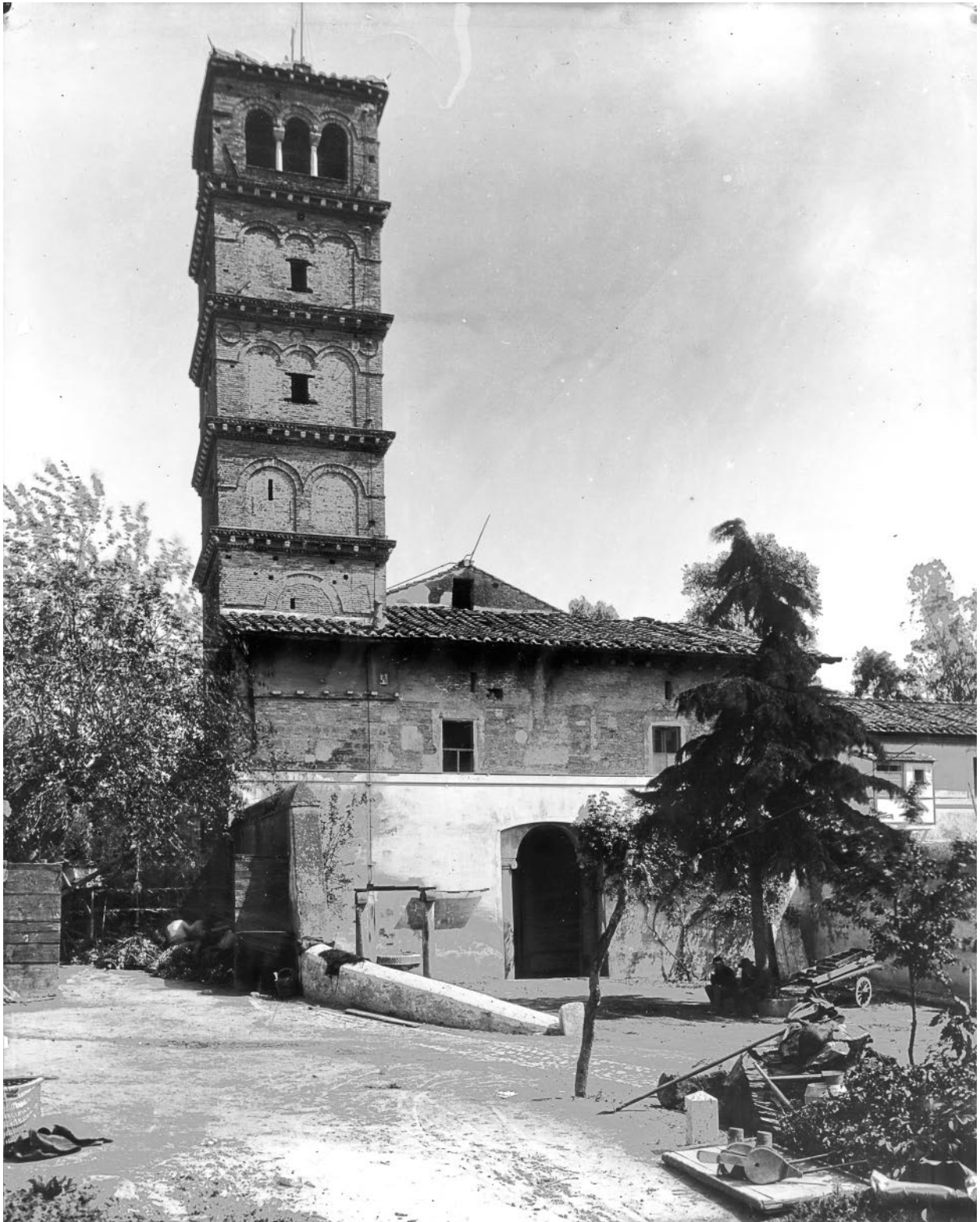
128. Rom, S. Giovanni a Porta Latina. Westfassade. Vorhalle mit Obergeschoß und Turm im Zustand um 1900 (Musei Vaticani)
