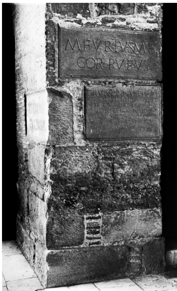
141. Rom, S. Giovanni a Porta Latina. Südwestliche Ecke des Turmuntergeschoßes. (Foto Claussen 2003)
