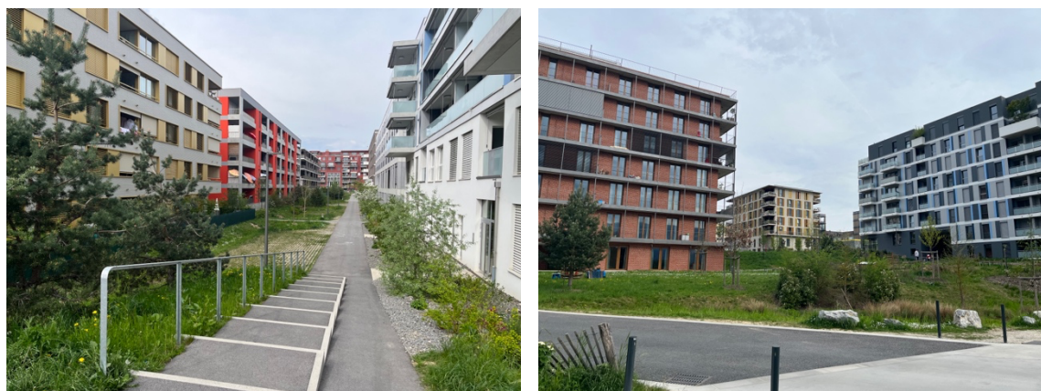
Figure 9 : Manque de cohérence esthétique des bâtiments des Vergers
