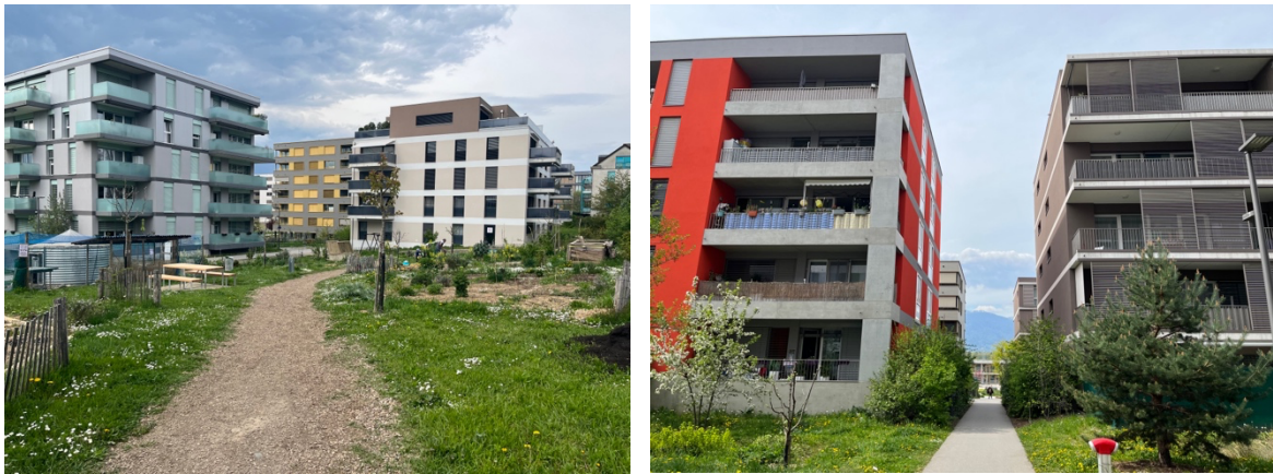
Figure 6 : Bâtiments en béton des Vergers
