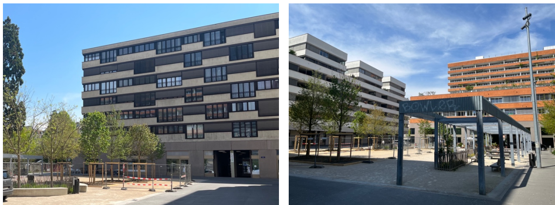
Figure 15 : Architecture et couleurs peu cohérentes de l'écoquartier Jonction
