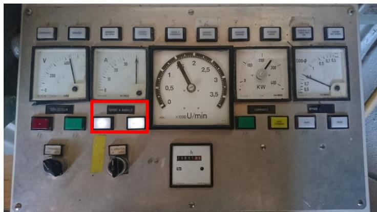
Figure 43: Tableau de commande indiquant le niveau haut et bas
