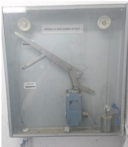
Figure 37: Mesure de niveau par flotteur
