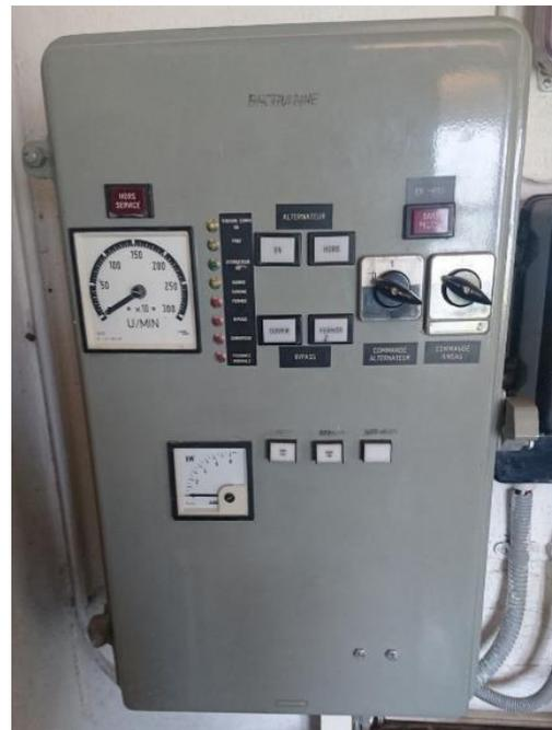
Figure 34: Tableau de commande de la turbine 3
