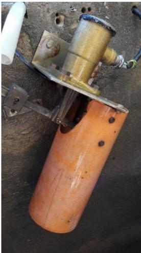
Figure 41: Interrupteur à flotteur
