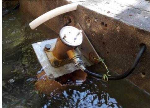
Figure 18: Interrupteur à flotteur
