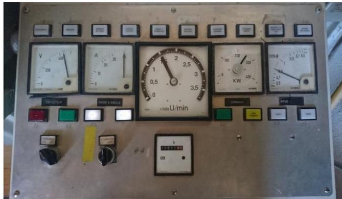
Figure 29: Tableau de commande de la turbine 1
